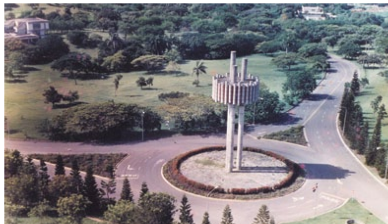
Vista aérea del tanque de agua del Campus Santiago en el año 1986.
